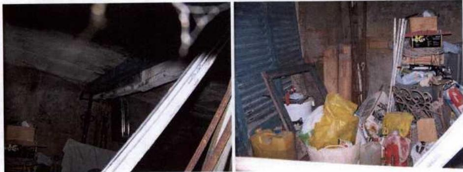
Estado del interior de la construcción, pudiendo apreciarse el colapso de la viga de hormigón de la estructura, que se encuentra apeada con puntales metálicos por amenaza de ruina, y el uso de la construcción como almacén de diversos enseres y materiales de construcción.
