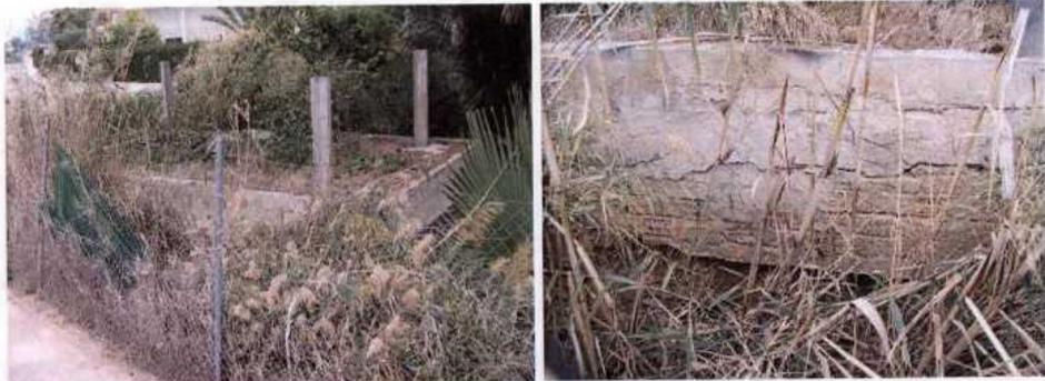
Aspecto exterior, desde el encauzamiento del Barranco de la Albufereta, donde se aprecia el pésimo estado de conservación y la falta de mantenimiento, tanto de la cubierta como de la fachada oeste.
