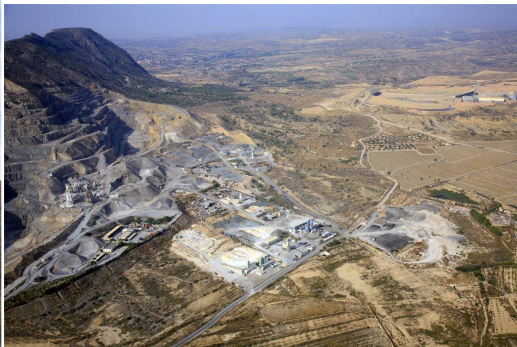
Vista de la cantera de áridos
