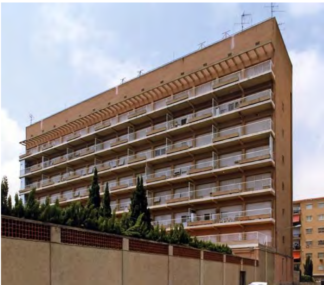
Fachada original actualmente modificada
