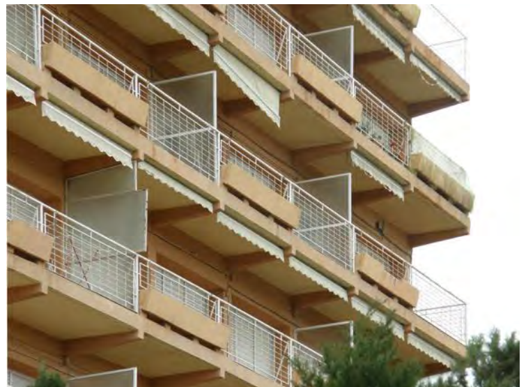
Fachada original actualmente modificada
