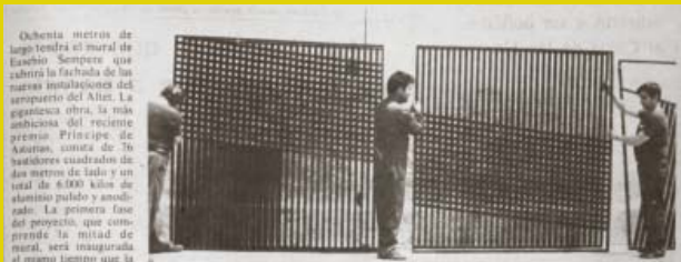
Foto de la construcción del Mural de 80 metros de longitud en el aeropuerto
