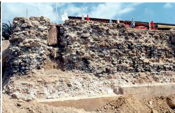
SILLERÍA Y TRADÓS DEL REVELLÍN DE TABARCA
