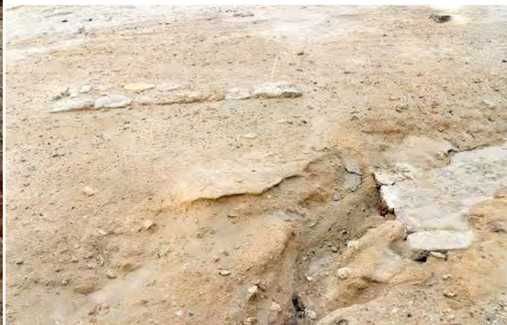
DETALLE DE ESTRUCTURA MURARIA EN SUPERFICIE
