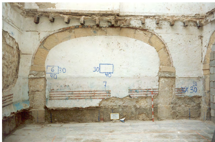
ARCO TIPO CARPANEL TALLADO EN PIEDRA
