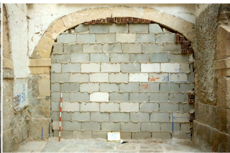
ARCO TIPO CARPANEL TALLADO EN PIEDRA
