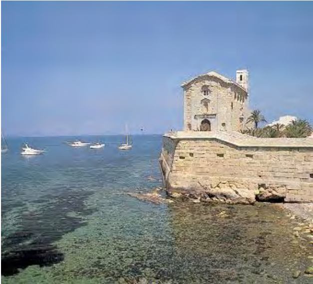
VISTA GENERAL DE LA IGLESIA Y SU ENTORNO
