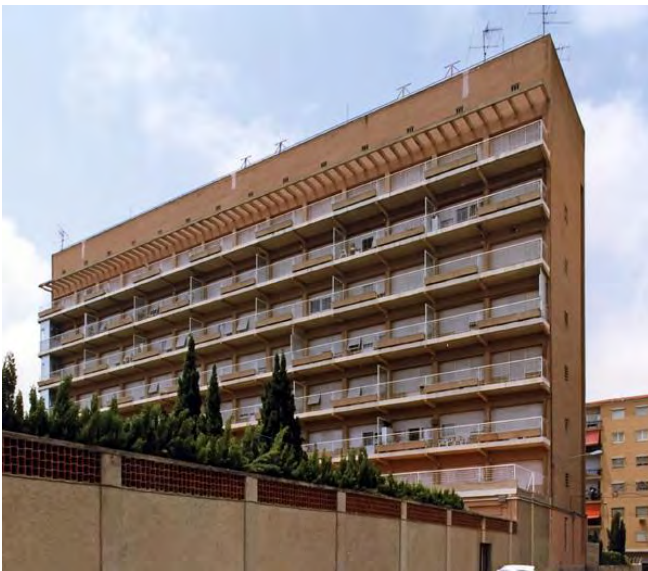
Fachada original actualmente modificada
