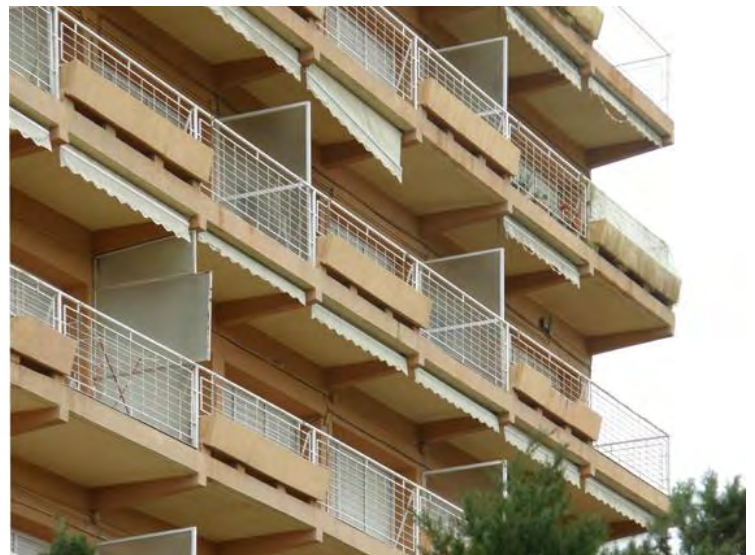
Fachada original actualmente modificada
