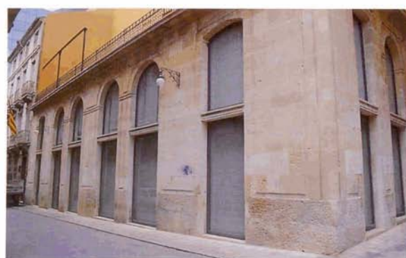
Fachada calle Labradores y calle San Isidro antes y después de la restauración.
