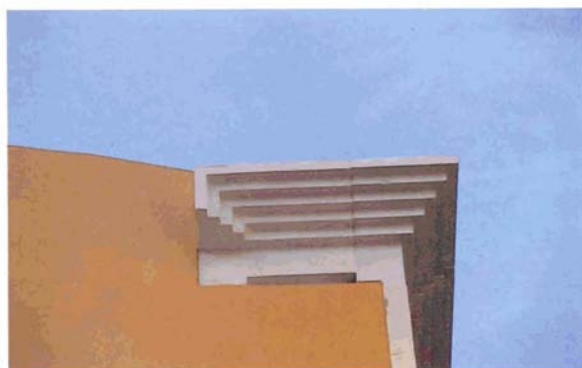
Detalle de la cornisa repuesta en el edificio principal.
