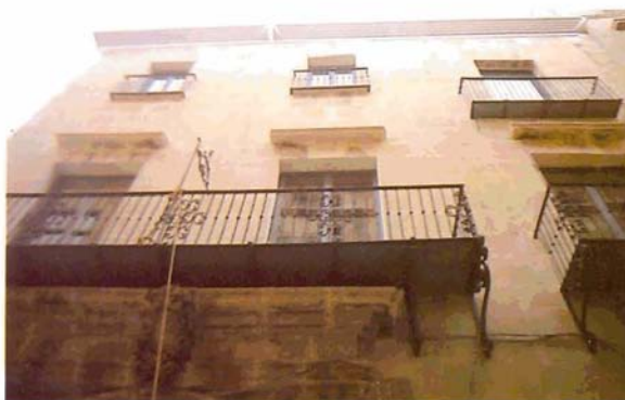
Fachada a Labradores vista anterior a la intervención y resultado.
