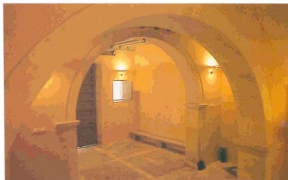
Conjunto del vestíbulo desde la escalera.
