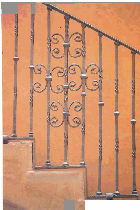
Aspecto de la baranda.
