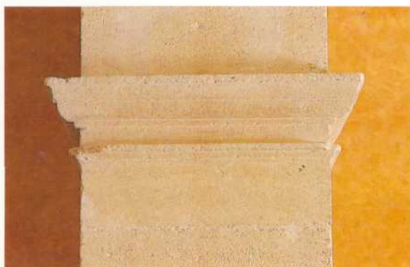
Detalle de la imposta en el vestíbulo.
