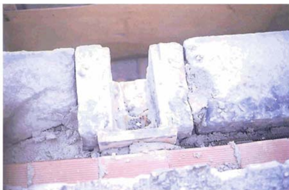
Aspecto del desagüe original de la cubierta.
