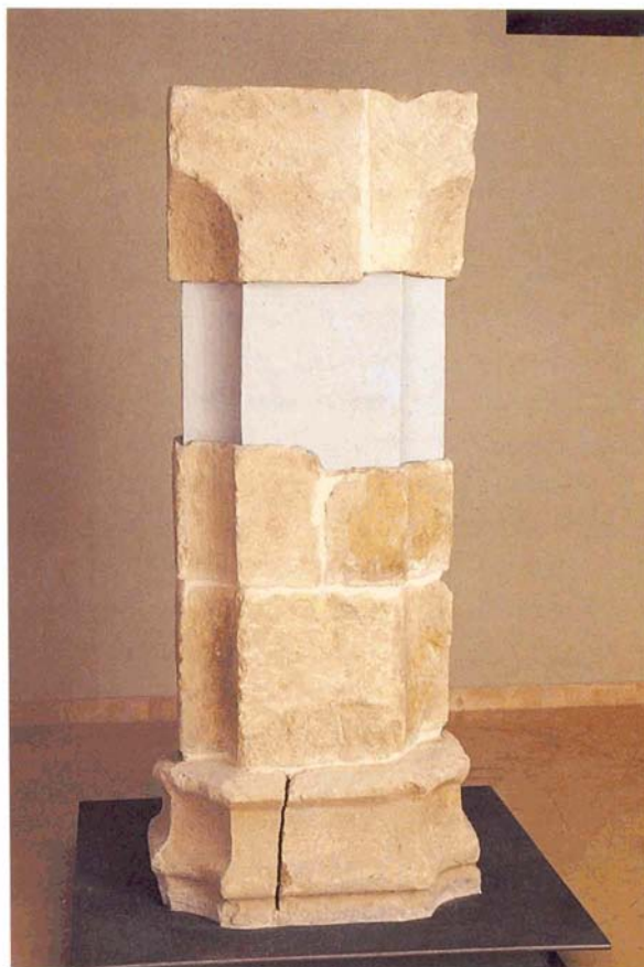
Reposición de la pilastra medieval.
