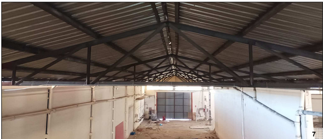
Fotografía nº 7: Vista general de las cerchas trianguladas tipo CER-3 y CER-4.
