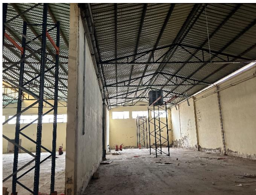
Fotografía 3. Vista interior nave
