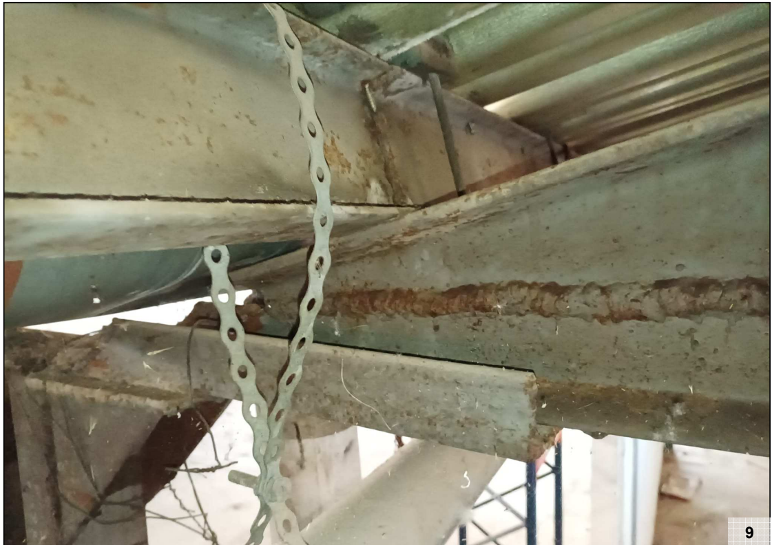
Fotografías nº 8 y 9: Vista y detalle del apoyo de la cercha tipo CER-3 y CER-4 en la cabeza de uno de los pilares centrales (2 UPN-100 empresillados).
