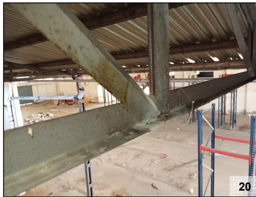
Fotografías nº 14, 15, 16, 17, 18, 19 y 20: Vista general de los puntos de corrosión existentes en los perfiles metálicos examinados y estado de conservación de las uniones soldadas tanto en los pilares como en las cerchas inspeccionadas.
