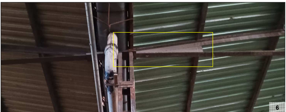
Fotografía nº 4: Vista general de una de las cerchas trianguladas con cresta tipo CER-1 y CER-2. Fotografía nº 5: Detalle de la cresta de la cercha analizada. Fotografía nº 6: Detalle del apoyo de la cercha tipo CER-1 y CER-2 en la cabeza de uno de los pilares centrales (2 UPN-100 empresillados).
