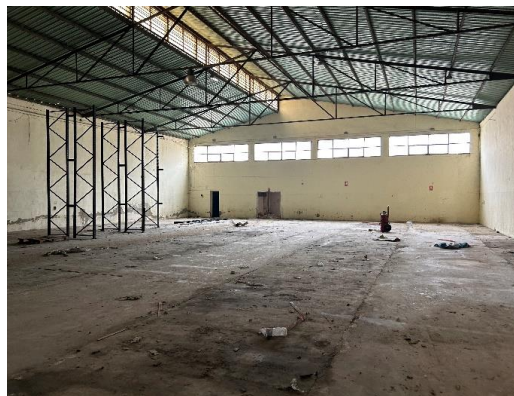
Fotografía 4. Vista interior nave
