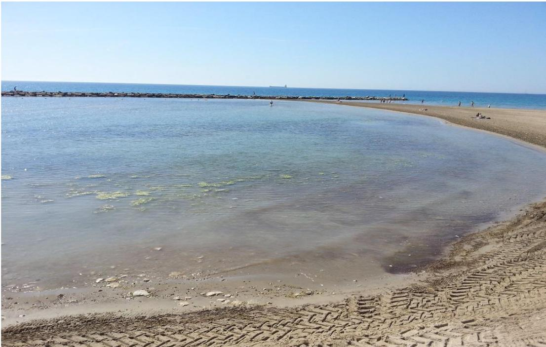
**Fotografía 14: Vista del tómbolo situado en la playa del Postiguet. Se aprecian en la superficie del mar, la presencia de algas nitrófilas (manchas color verde) que indican síntomas de eutrofización de las aguas. Se debe al confinamiento de las aguas provocado por el dique exento y los aportes de nutrientes procedentes de los aliviaderos urbanos**
