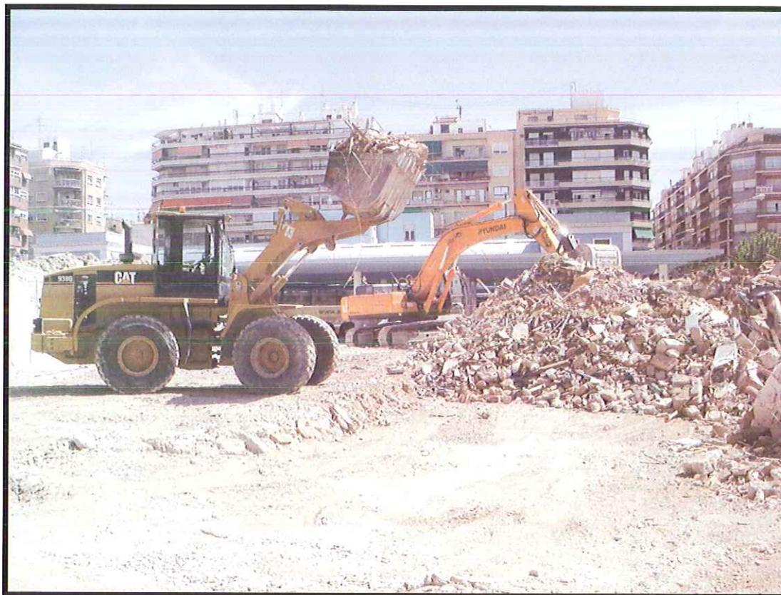
Detalles de la demolición de 4 edificios anexos a la antigua estación de autobuses, mediante pala cargadora y retroexcavadora.
