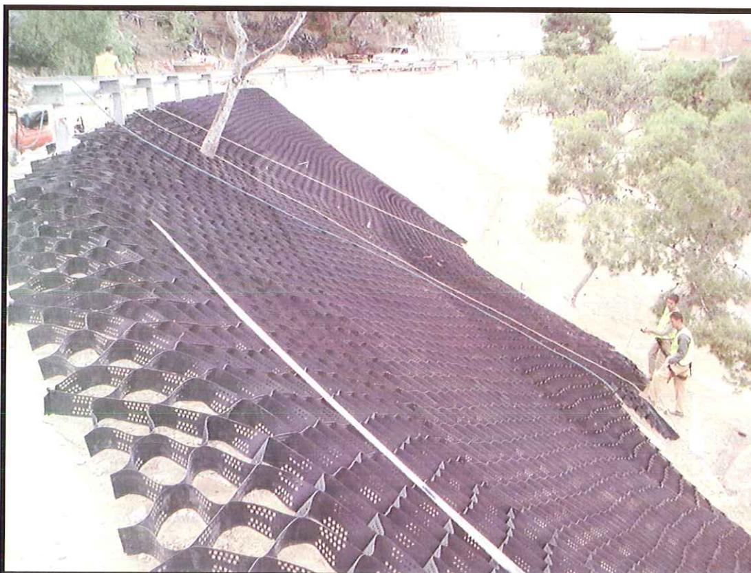
Detalle de la consolidación de taludes mediante el sistema micro-celdas, en la ejecución de Ordenación y restauración paisajística del sector sur de Castillo San Fernando, donde se aprecia la utilización del sistema de retención anticaídas en estos trabajos.
