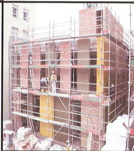
Detalle de la ejecución del nuevo C.P. San Roque, en fase revestimiento de fachada mediante el enlucido con monocapa
