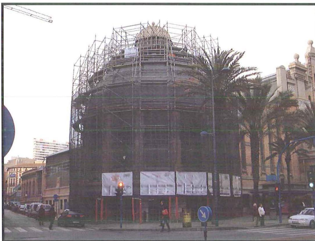
Detalles del sistema de andamio tubular normalizado, empleado para la remodelación de la cubierta de la cúpula del mercado Central, vista desde la Avda. Alfonso El Sabio.
