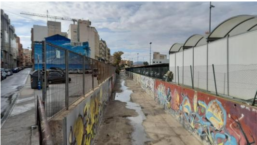
Borde de baja calidad del Barranco de San Blas
