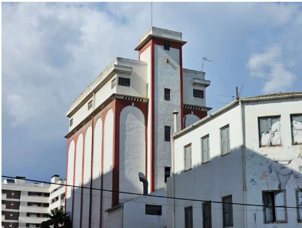
5.Vista del silo desde la Avda. de Elche
