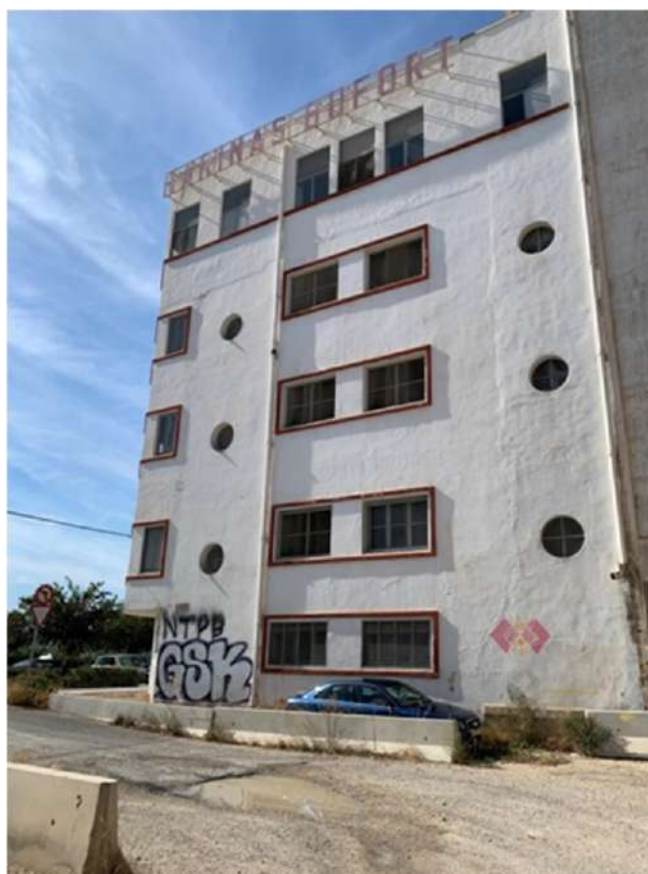
4. Vista de la fachada de la fábrica (edificio principal) desde la Calle García Andreu
