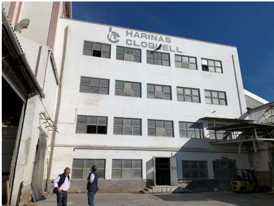
4. Vista de la fábrica (edificio principal) desde el patio.
