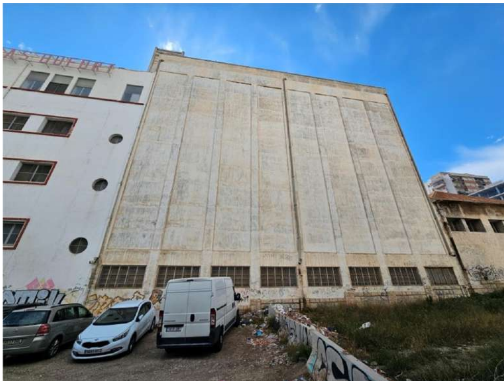
5. Vista de la fachada del silo desde la Calle García Andreu
