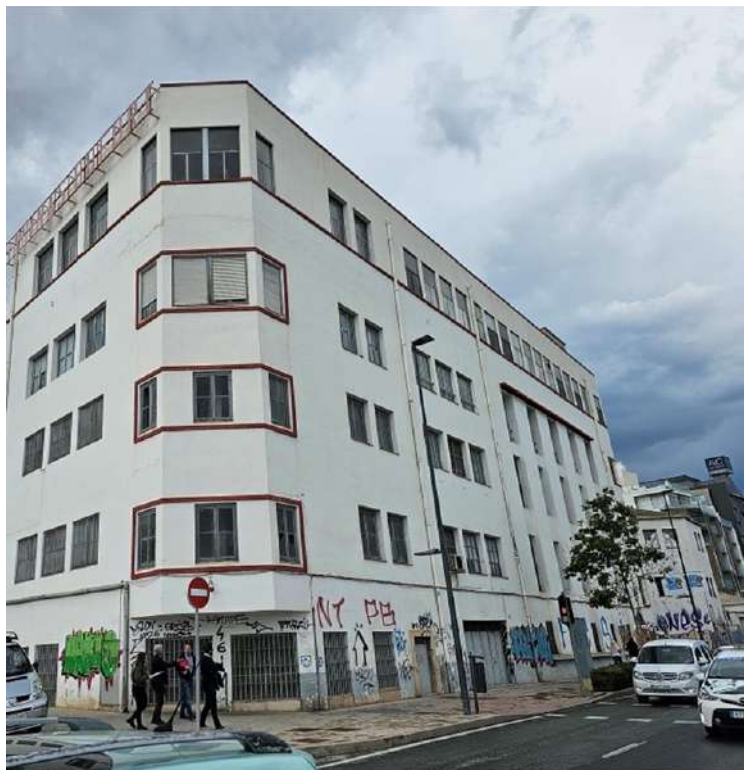
3. Vista de las fachadas desde el cruce de Calle Dr. Just y Avda. de Elche
