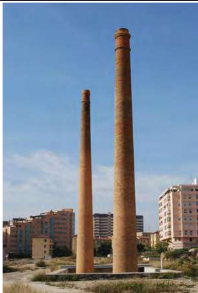
1. Vista general de las chimeneas.
