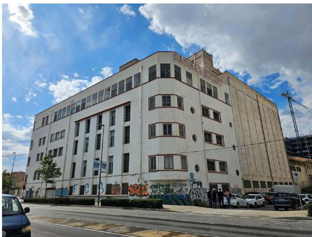
2. Vista de la fábrica (edificio principal) y del silo desde la Avda. de Elche
