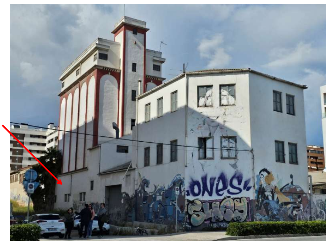
6.Vista de la fábrica señalando el muro de la construcción original
