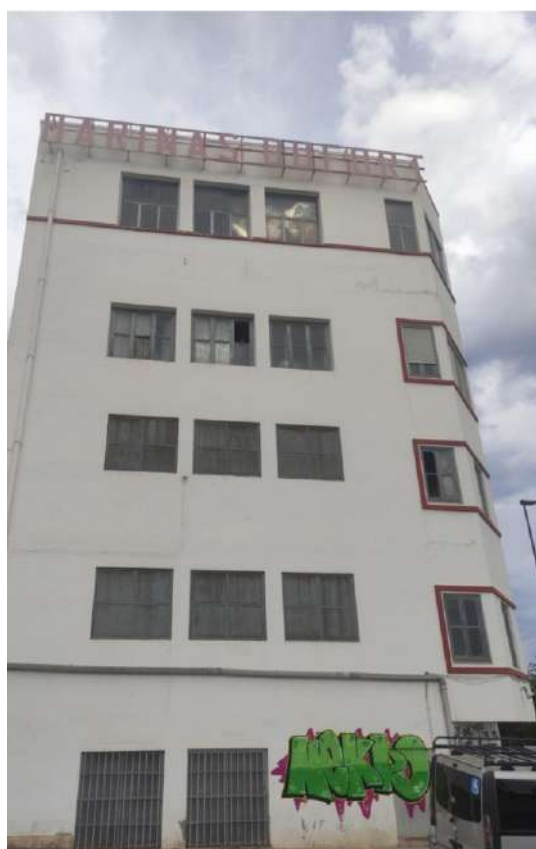
6. Vista de la fachada de la fábrica ( edificio principal) desde la Calle Dr. Just
