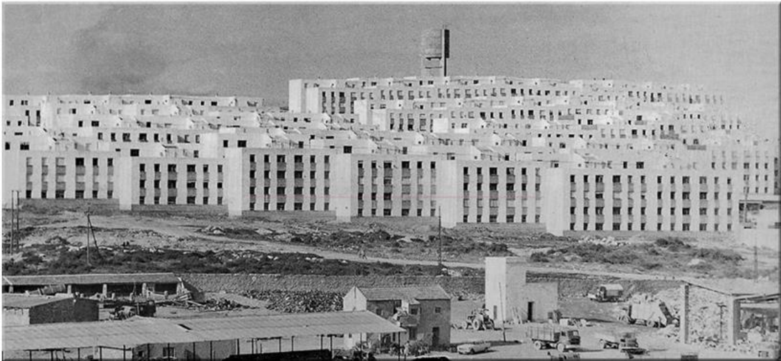
Figura 3. 1973. Construcción de las viviendas del polígono A del barrio de Juan XXIII. Fuente: Un siglo en imágenes.
