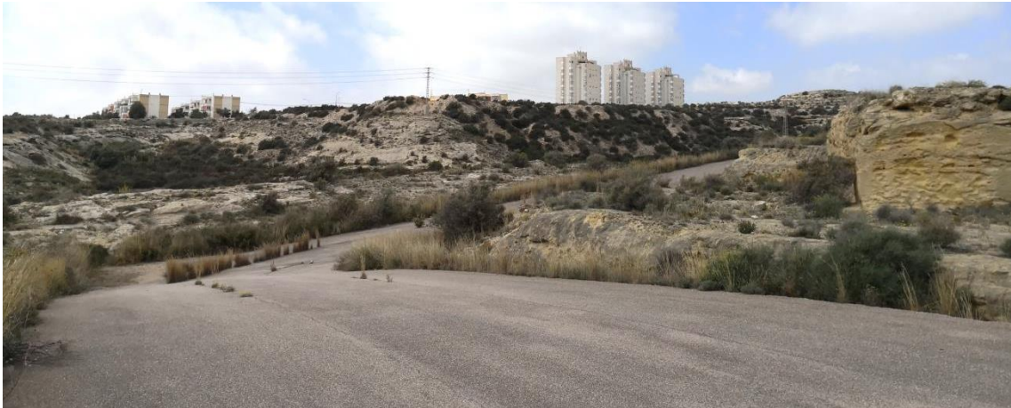
Figura 14 Carretera ejecutada en el interior del ámbito.
