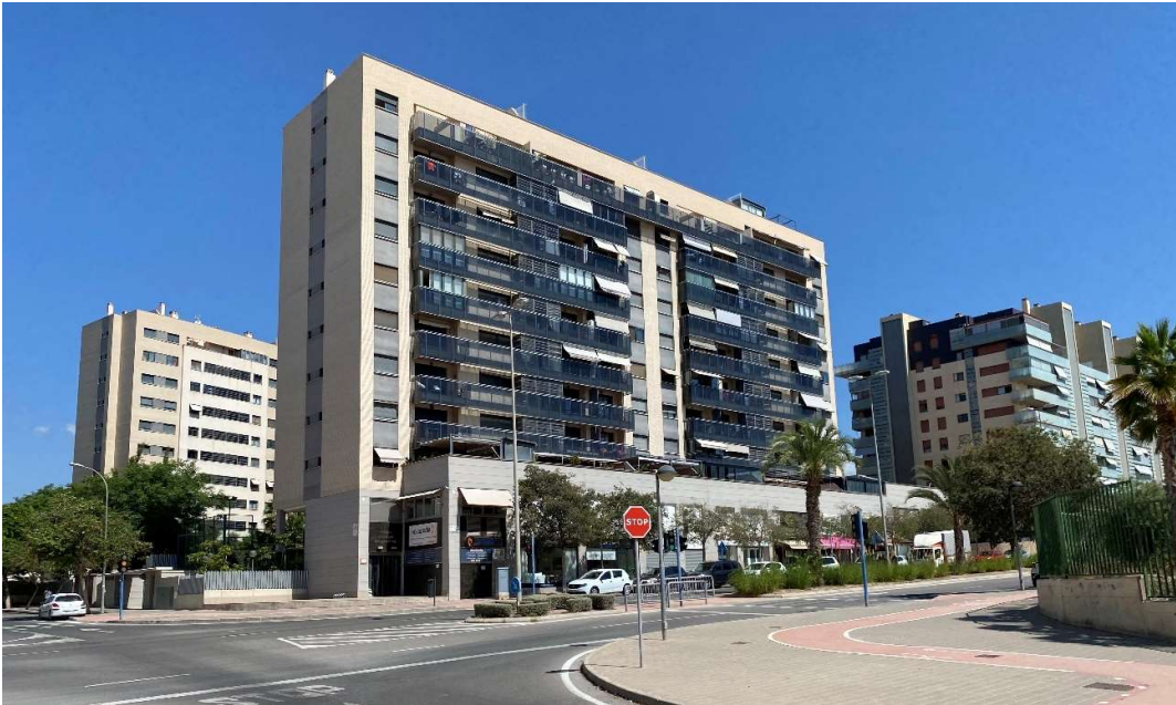
Imagen: Bloque de viviendas en el barrio de Juan Pablo II. Fuente: IDOM
