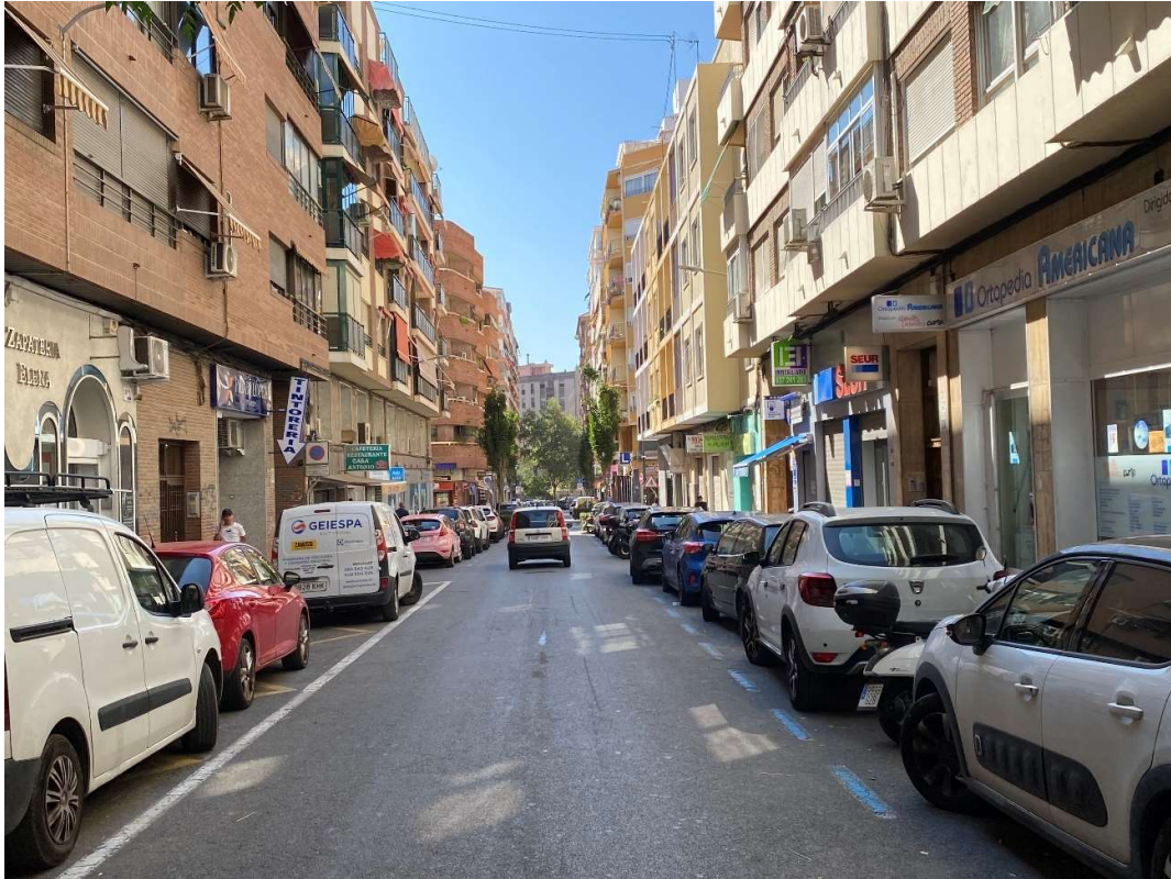
Imagen: Sección de calle tipo en el Ensanche de Alicante. Fuente: IDOM
