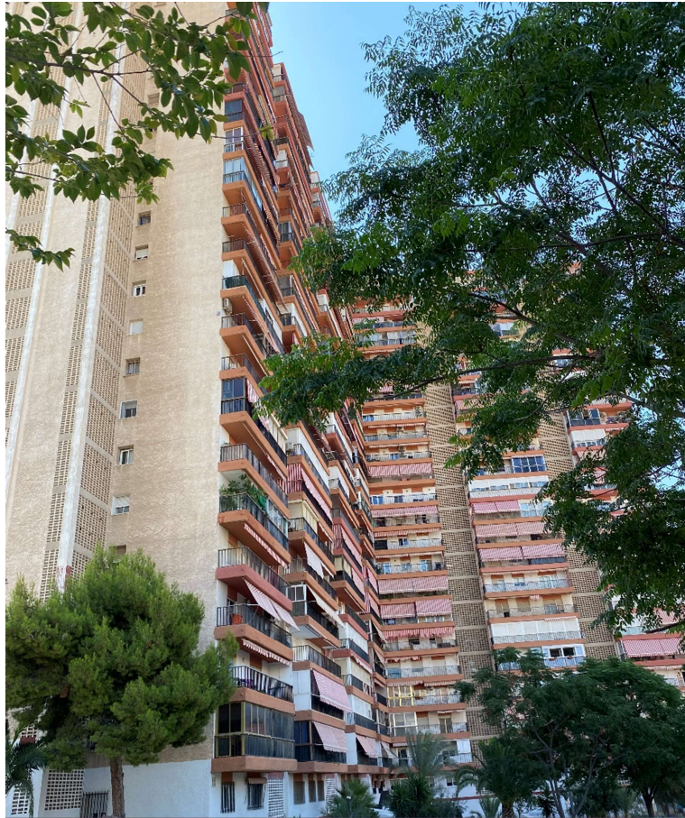
Imagen: Edificio La Colmena, en el barrio de San Blas – Santo Domingo. Fuente: IDOM
