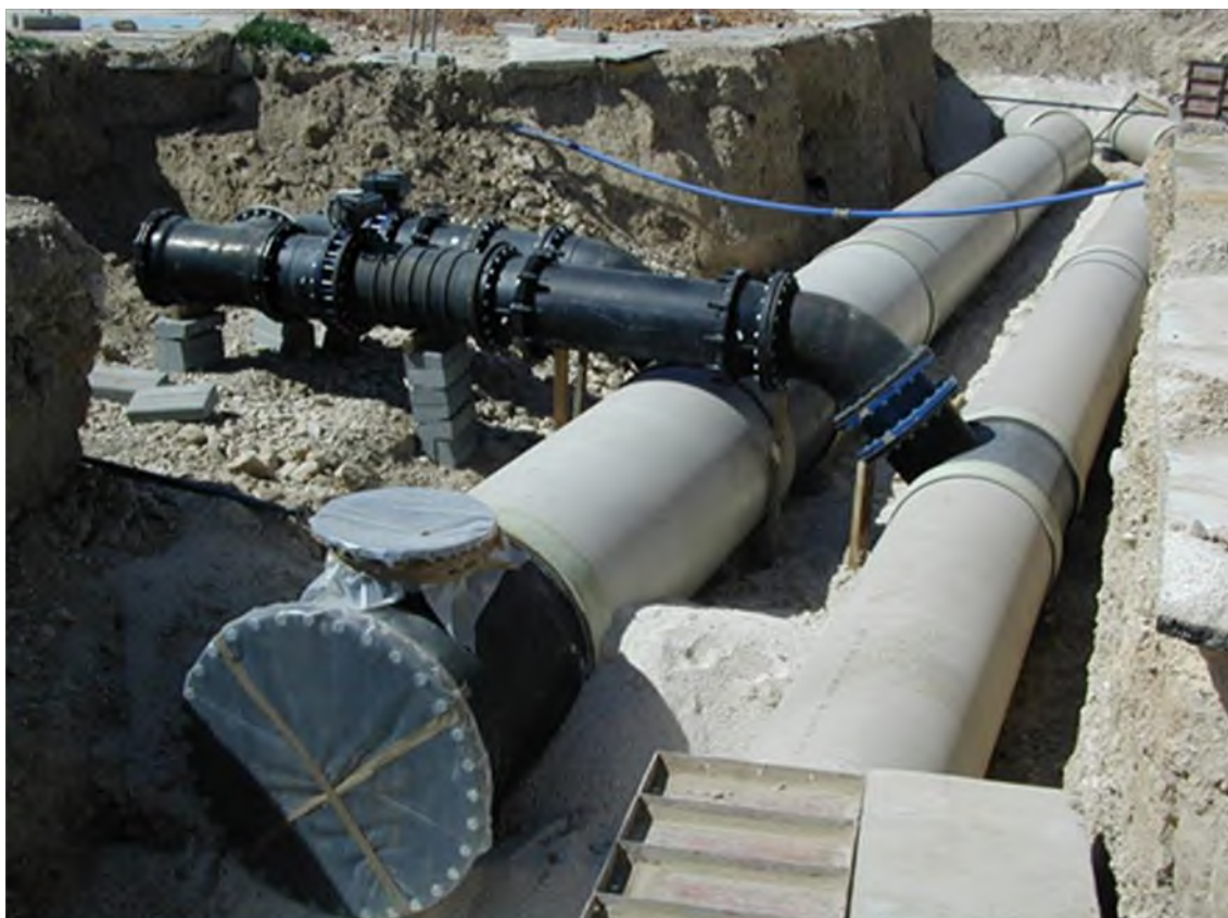
Figura 21 Construcción de canalizaciones \varnothing 1200 y 900 mm de P.R.F.V. en sustitución del Canal del Cid y un tramo del doblaje \varnothing 900 mm Rocla. Paraje La Molineta (Petrer)
