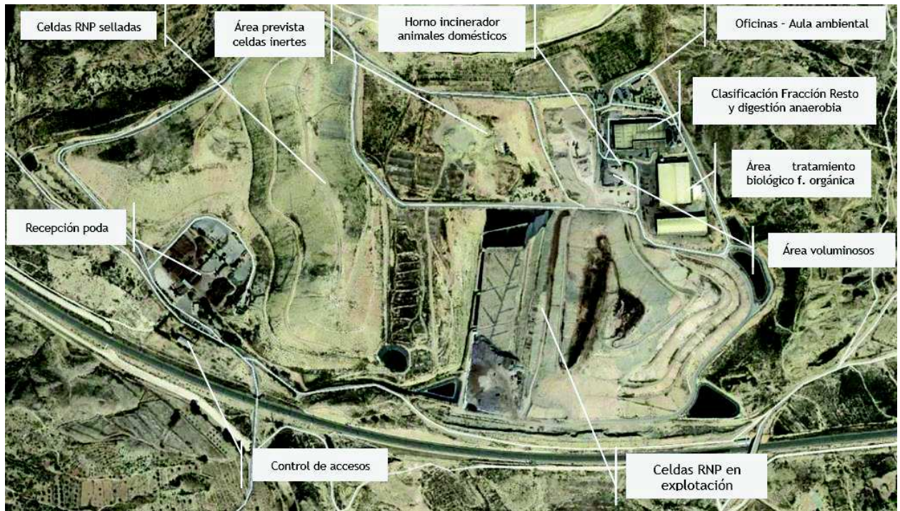
Ilustración 2. Áreas tratamiento CETRA. Instalaciones de valorización y eliminación de residuos
