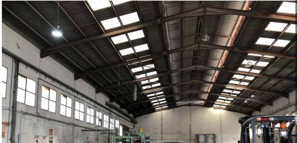
Foto cubierta nave producción (sector 3). Ventilación corrida cenital.
