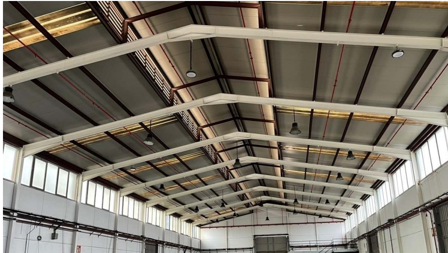
Foto cubierta nave almacén (sector 2). Ventilación corrida cenital.
