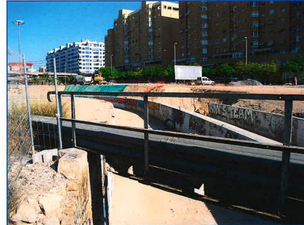
Foto nº11: Cruce del encauzamiento del barranco bajo las vías del FFCC.
