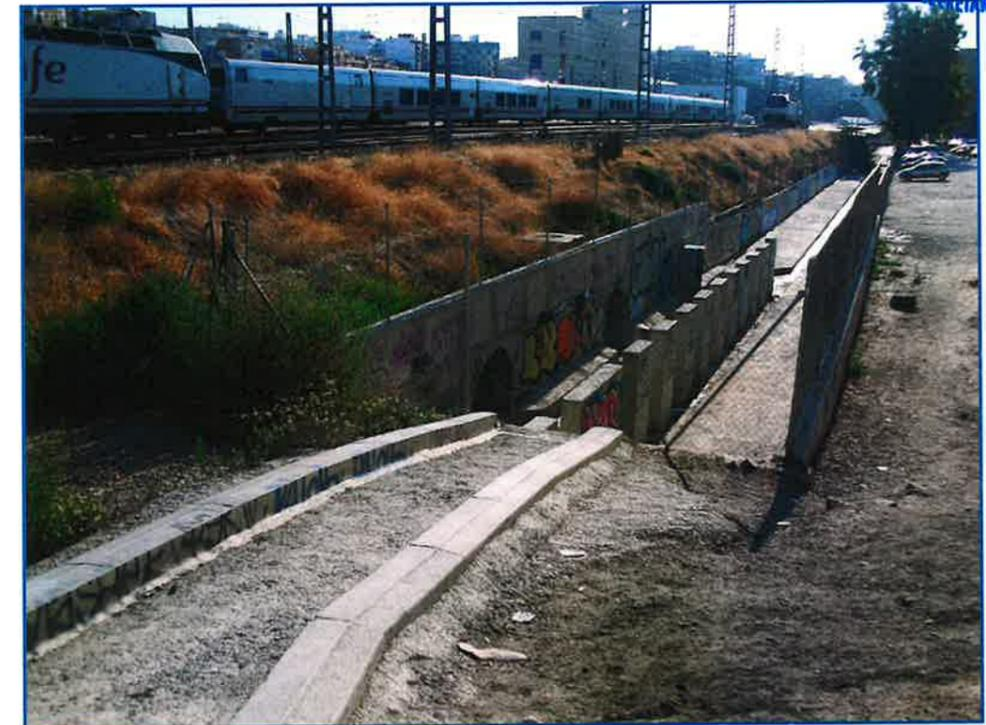
Foto nº23: Idem foto anterior. Detalle hincas drenaje bajo playa de vías de FFCC. 4xDn-1800 mm.
