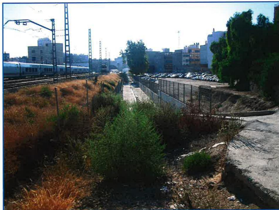
Foto nº22: Foto hacia aguas abajo desde la C/Pérez Jordá de Alipark (prolongación de C/Tarrasa). Punto de final de sección subterránea y paso nuevamente a sección abierta.
