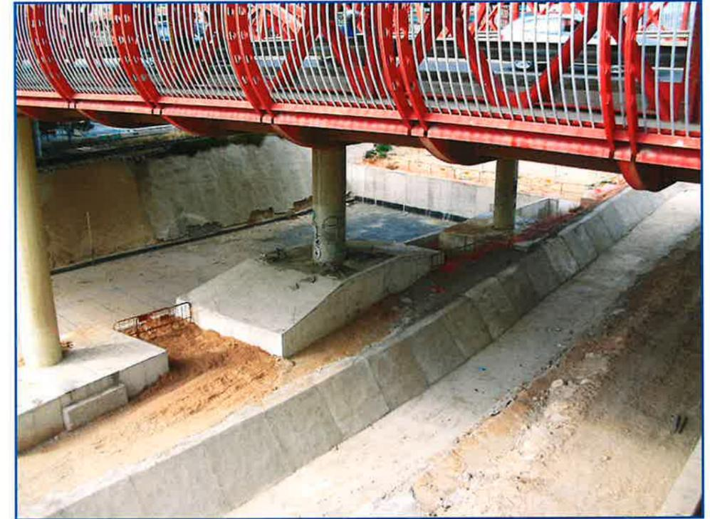
Foto n°7: Detalle del paso de la trinchera junto a las pilas del puente. Al fondo, losa del cajón del FFCC.
