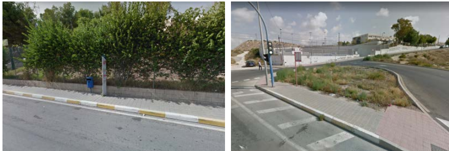
Imagen 11. Paradas de autobús en c/ Barítano Paco Latorre
