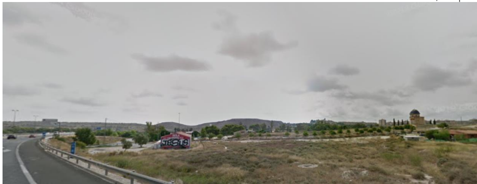
04. Vista del ámbito desde la Autovía A70
