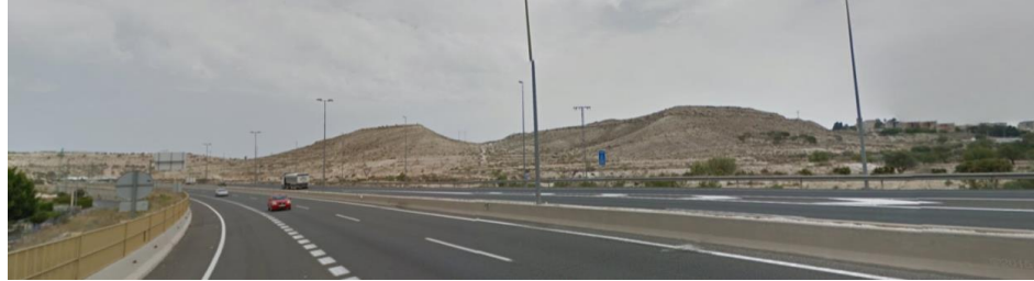
05. Vista del ámbito desde la Autovía A70
