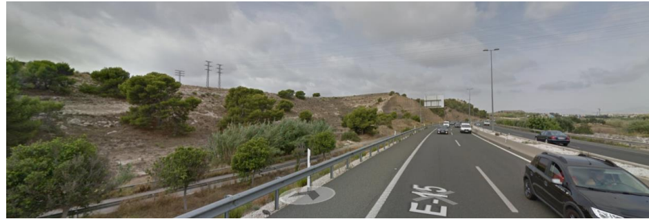
07. Vista del ámbito desde la Autovía A70
