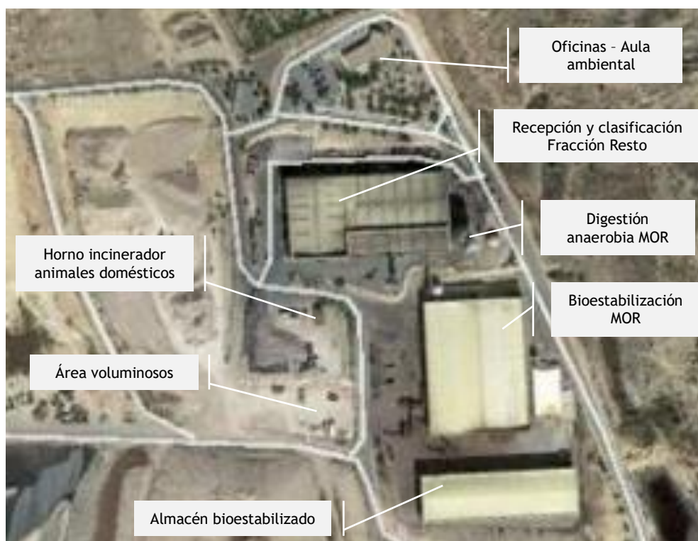
Ilustración 4. Plataforma ubicación actual Planta Tratamiento fracción RESTO
