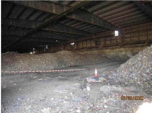
**Fotografía 30.** Vista material en proceso bioestabilización en zona solera ventilada
