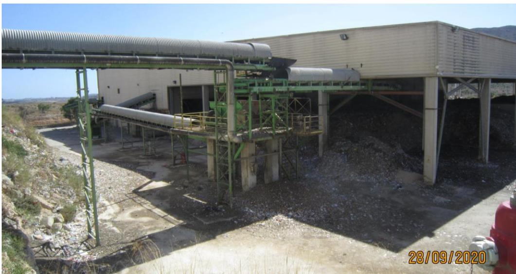
**Fotografía 25.** Vista cinta alimentación MOR granulometría 40-80 mm desde zona clasificación a tromel de mezcla con material de aporte y digestato
