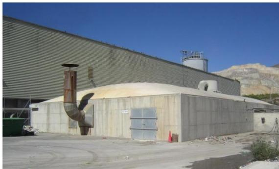
**Fotografía 36.** Vista biofiltro cubierto con scrubber
