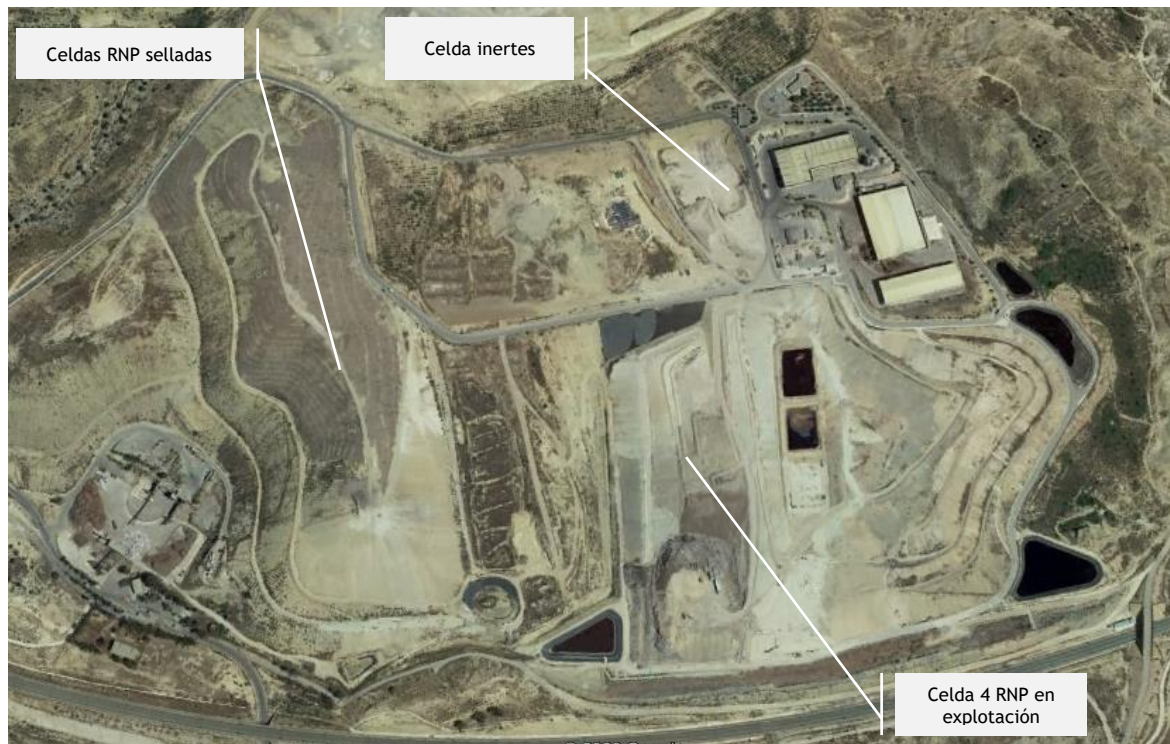
Ilustración 4. Instalaciones de eliminación de residuos RNP e inertes del CETRA
