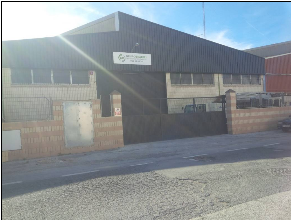
Foto 4: Vista de la fachada de la actividad desde la Calle Arquitecto Miguel de Real.
