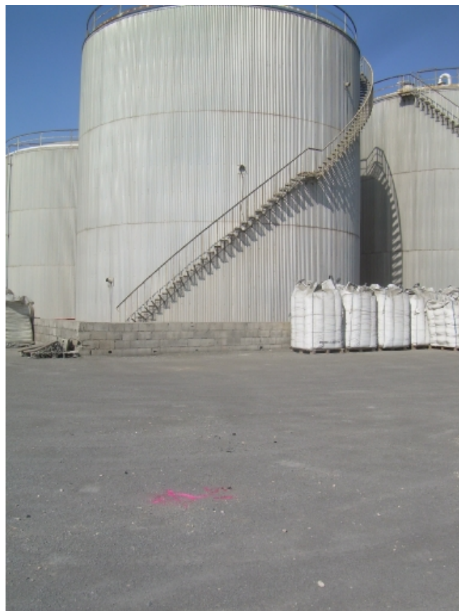
Fotografía 2: panorámica hacia el oeste donde se aprecia la ubicación del S.R.V.1. El futuro tanque se ubicará junto a los ya existentes de menor tamaño, como los que se muestran en la imagen.
