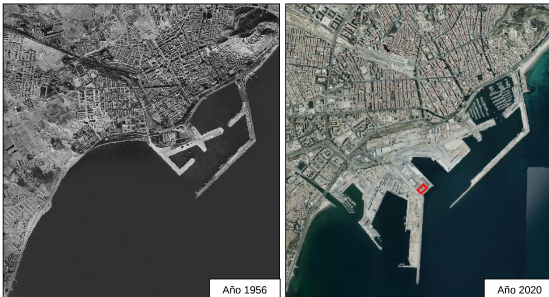
FIGURA 2. Terreno ganado al mar en la ampliación del Puerto.
