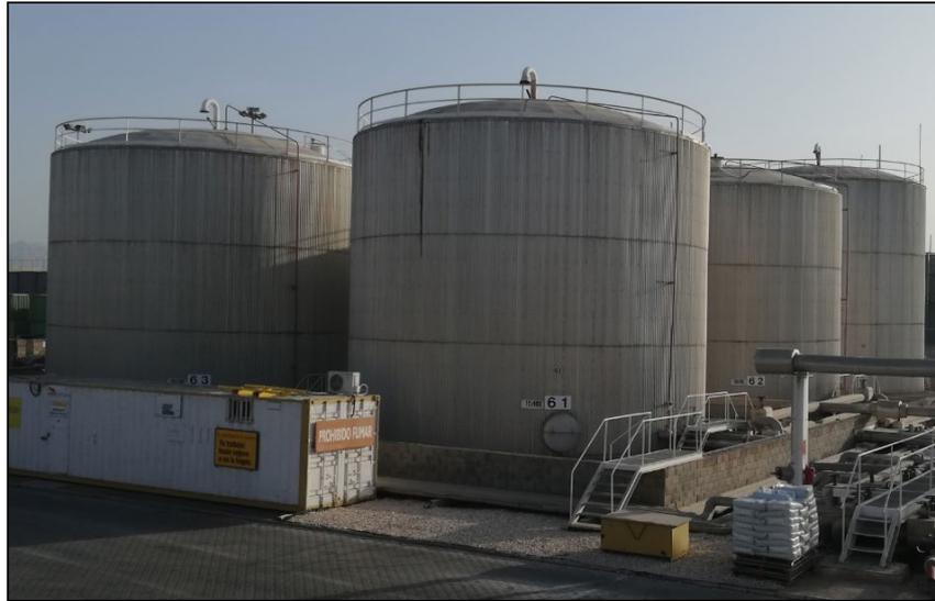
**FOTO 9.** Tanques de almacenamiento de betún base
