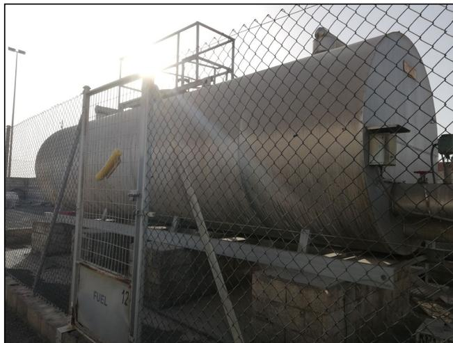
FOTO 2. Tanque de almacenamiento de gasóleo 1 (30 m<sup>3</sup>).
