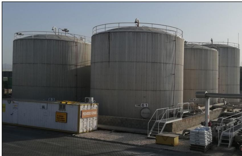
FOTO 1. Tanques de almacenamiento de betún base
