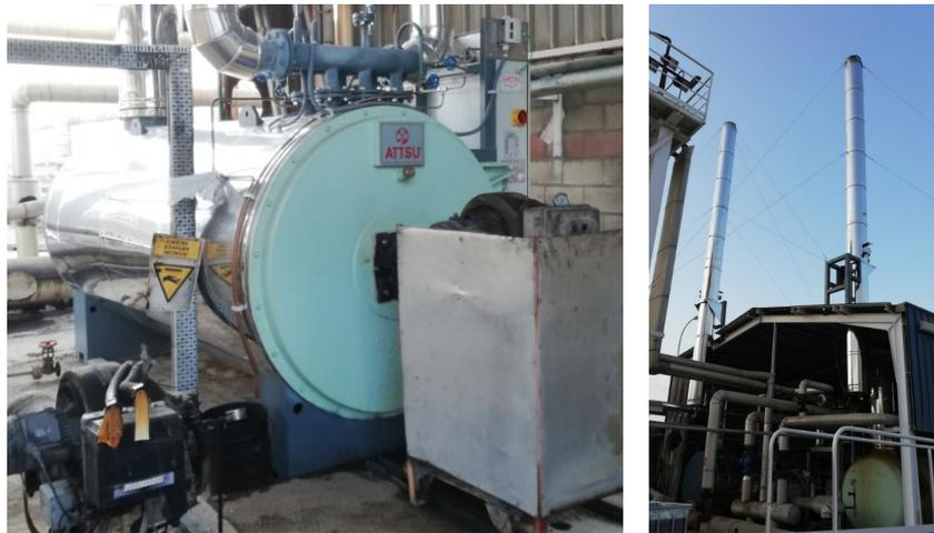
FOTO 7. Caldera de nueva instalación y chimeneas
