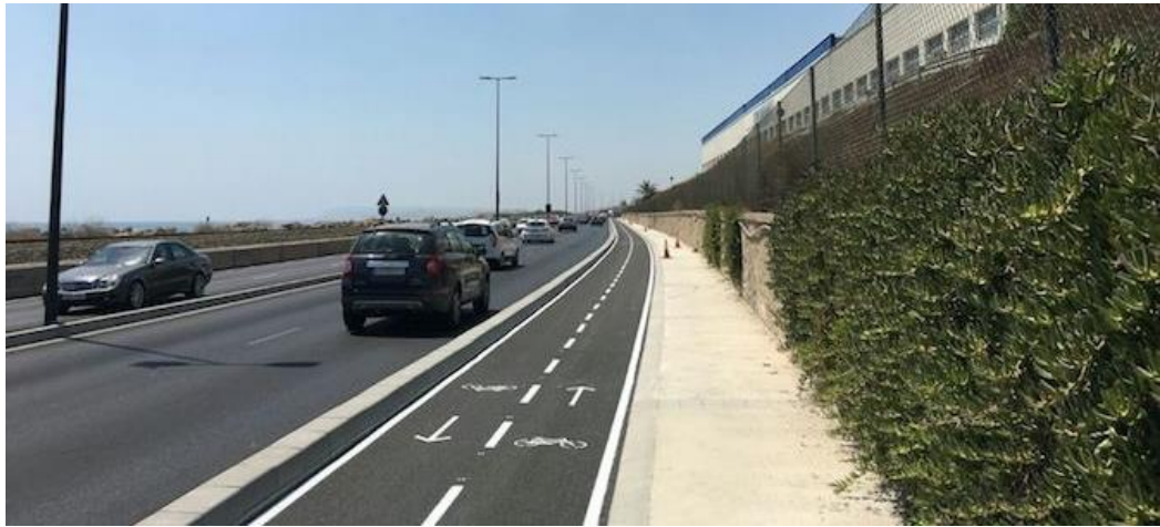
Carril bici en la avenida Elche (N-332) a la altura de Aludium
