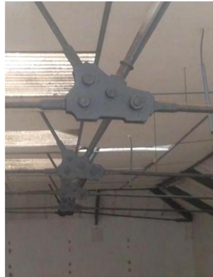
11. Detalle de la estructura metálica de la cubierta.
