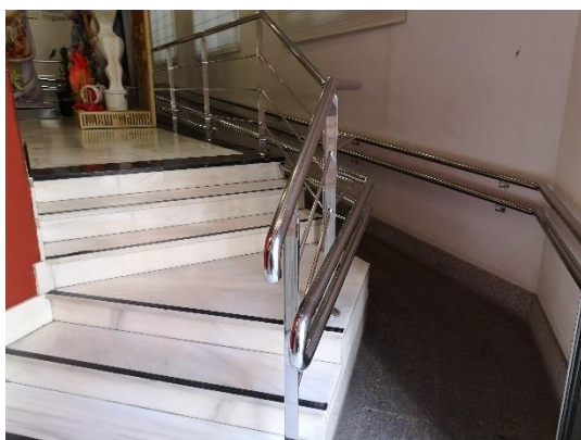
Inicio de la rampa y escalera de acceso.
