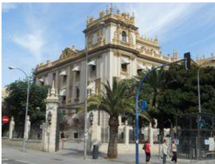
Fachada del Palacio Provincial de Alicante y puerta de acceso.
