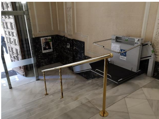
Escaleras de entrada con salvaescaleras.
