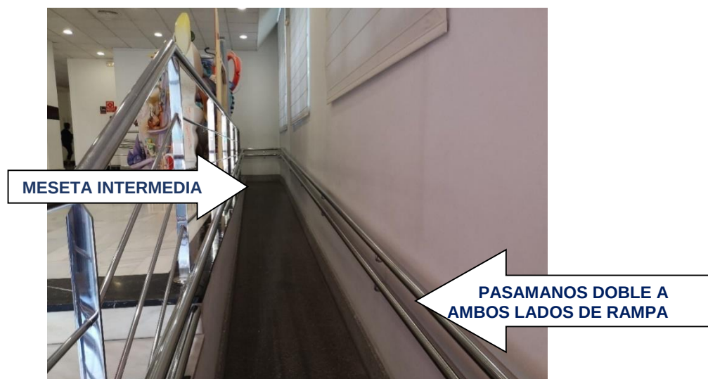
Rampa de entrada al Museu de Fogueres
