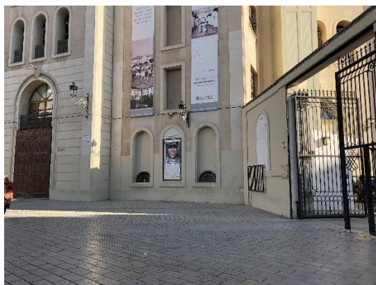
Puerta de acceso lateral.
