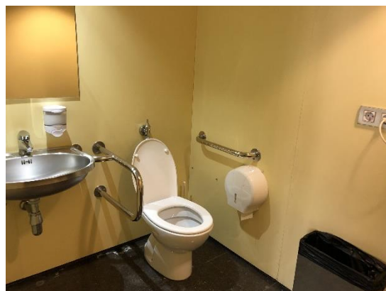
Interior del aseo adaptado.
