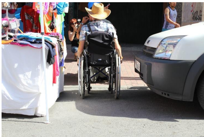
Zona de paso en punto de la acera sin rebaje.
