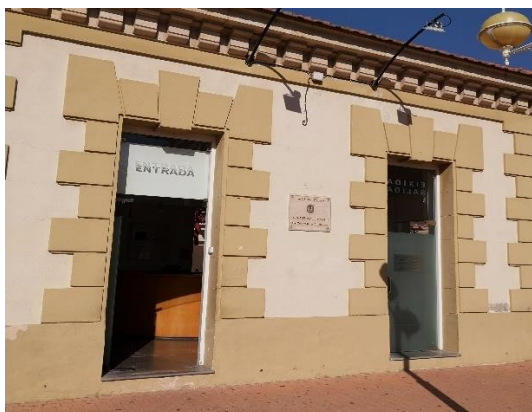
Punto de acceso y mostrador de información.
