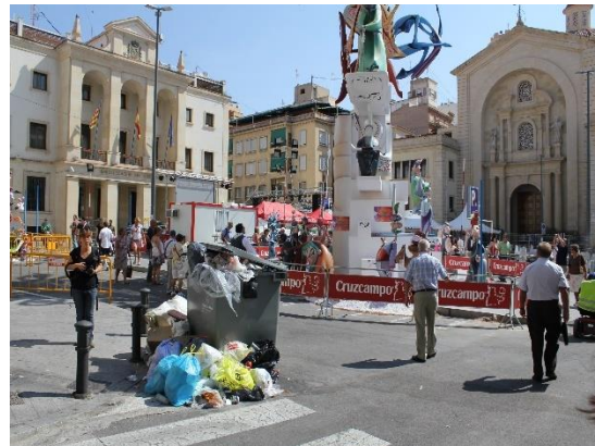
Contenedor interrumpiendo rebaje.
