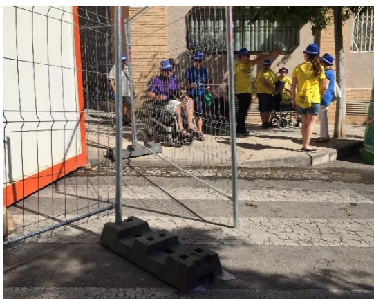
Rebaje peatonal parcialmente ocupado por el vallado.
