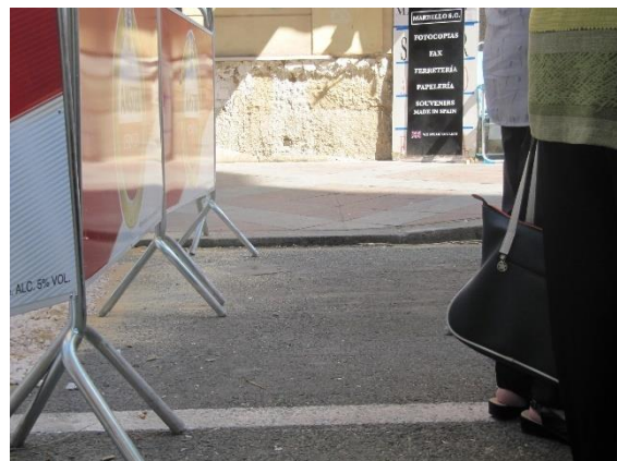
Paso en zona sin rebaje.
