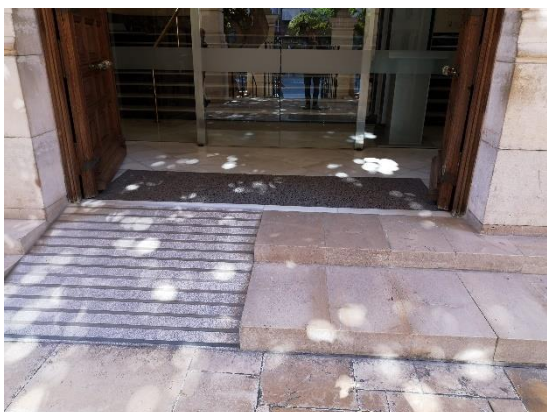
Puerta de acceso al edificio.
