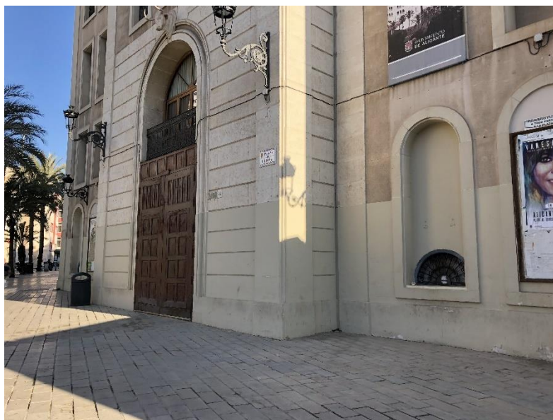
Fachada de la Plaza de Toros y puerta de acceso.
