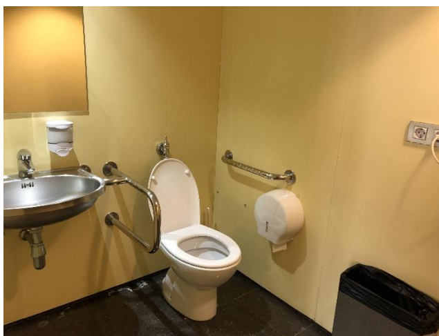
Aseo adaptado con barra de apoyo en la zona de transferencia no abatible.
