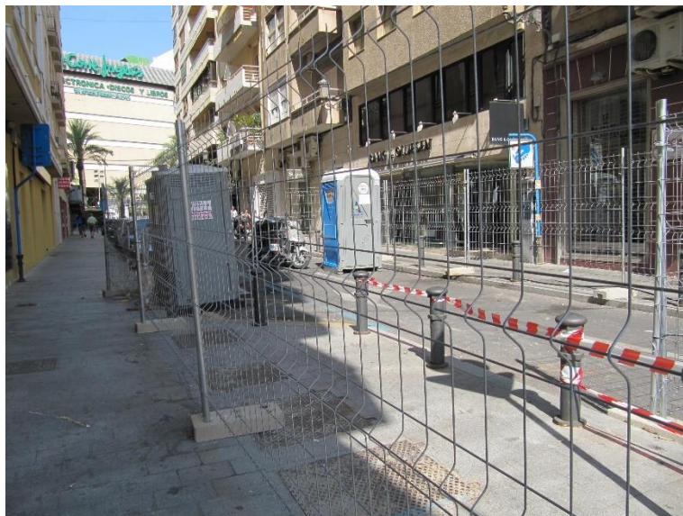
Ejemplo de estrechamiento de acera.
