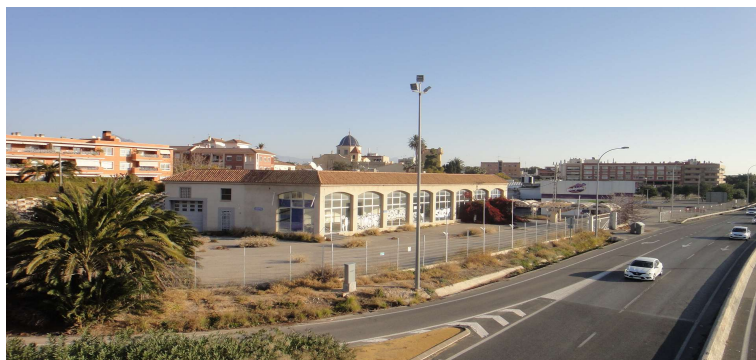
Imagen de la zona de ordenación B, tomada desde pasarela peatonal ubicada sobre la avenida de Denia.
