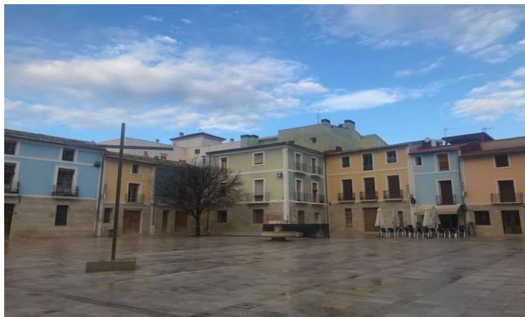
Imagen de las traseras de las nuevas edificaciones desde la plaza de Luis Foglietti.
