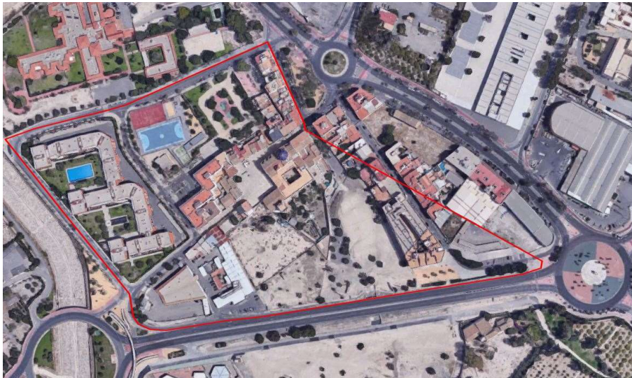
Imagen del estado actual.
