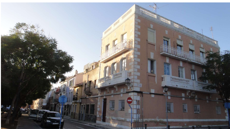
Imagen de la calle Barranquet. Estado actual.
