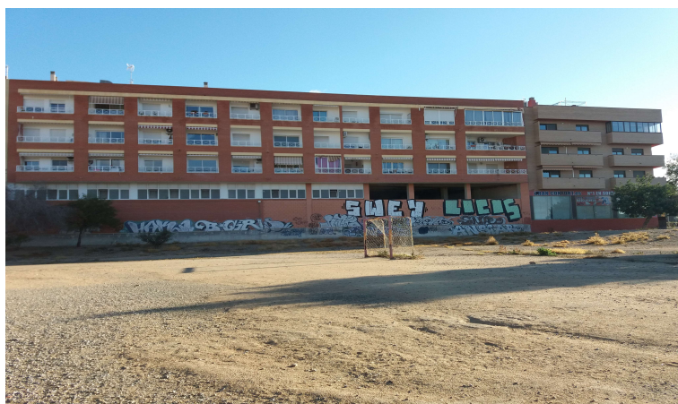
Imagen desde la Explanada de las viviendas sitas en calle Verónica.
