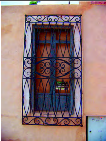
Cerrajería en ventana.
