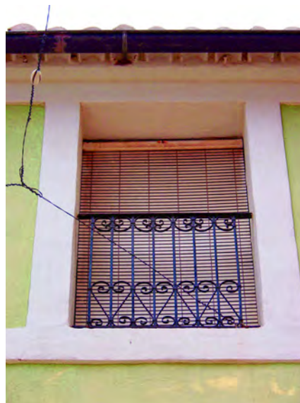
Cerrajería de hierro fundido.
