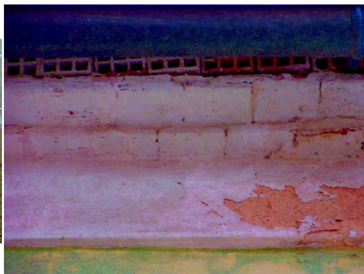
Alero de ladrillos superpuestos.
