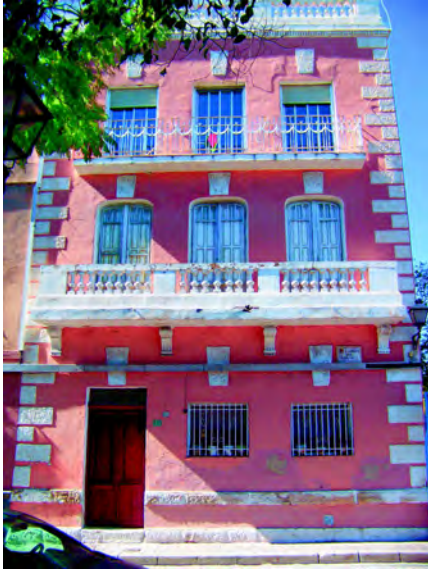
Fachada a calle Barranquet.
