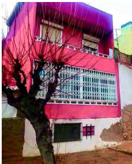
Alineación a vial fachada trasera. Impropio.
