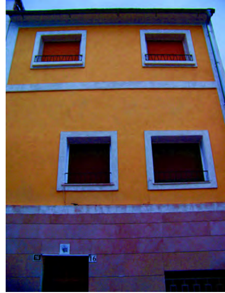
Huecos sin proporción vertical. Impropio.
