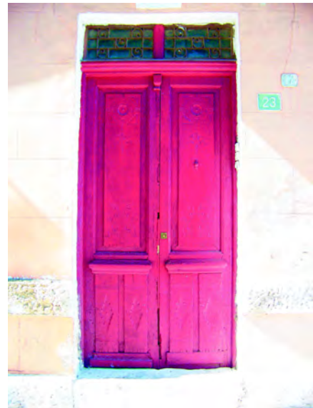
Detalle de carpintería.
