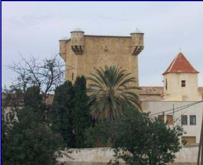
RP.55 TORRE DE SANTA FAÇ (localización ver plano EP-06.2)
