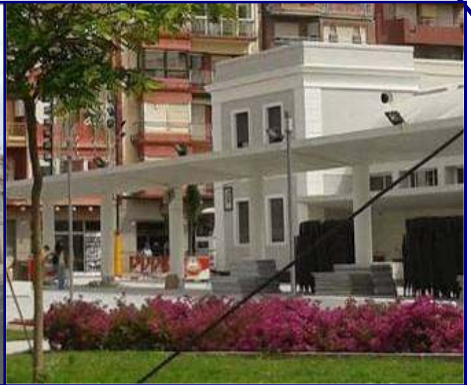
RP.02 ANTIGA ESTACIÓ D'AUTOBUSOS I MARQUESINA. (localización ver plano EP-06.2)
